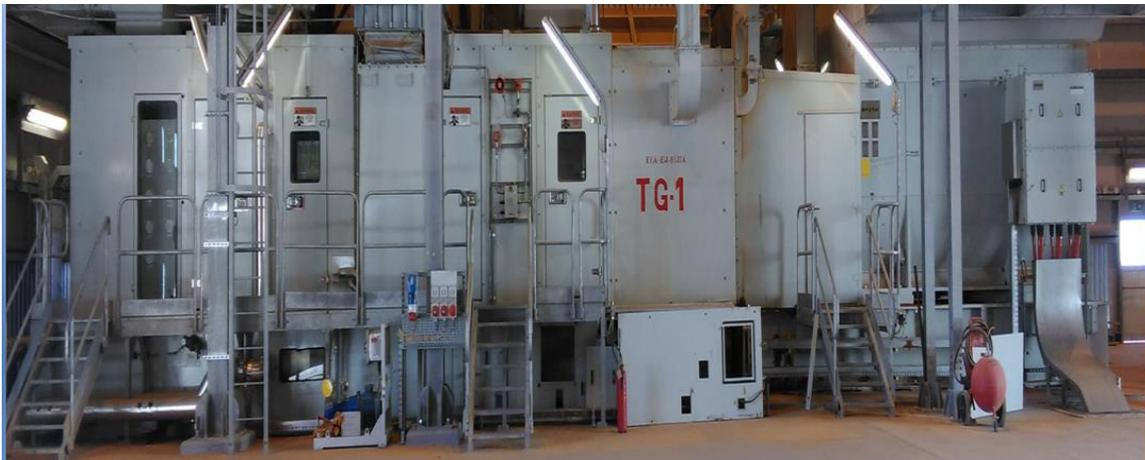
Figure III.1 : Schéma du turboalternateur de la nouvelle centrale électrique
